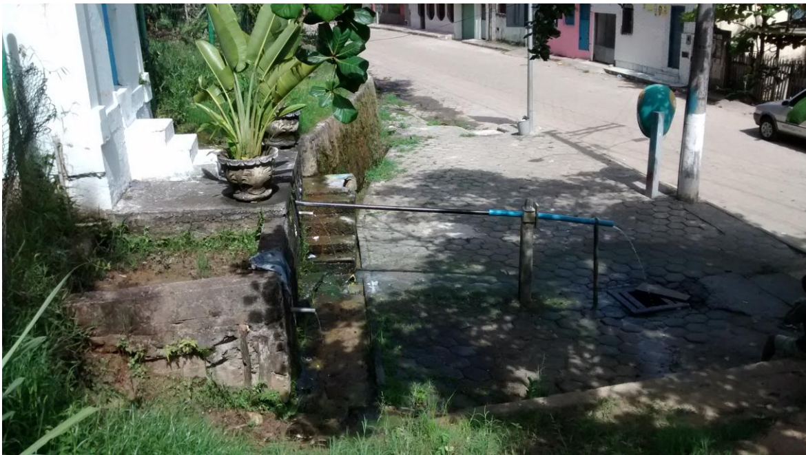
Foto 12 - Vista do reservatório abaixo dos vasos e da bica em ferro fundido e pvc pba, com lançamento na grelha
