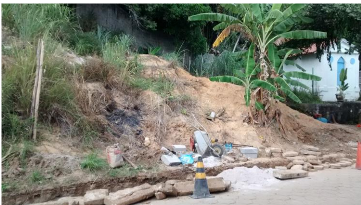
Foto 06 – Trecho a ser escavado e contido
