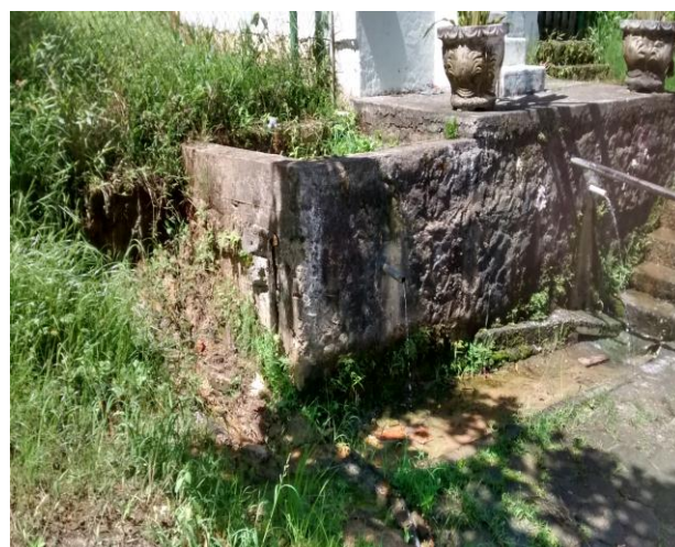
Foto 14 - Reservatório assoreado
