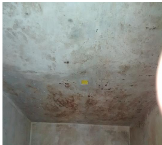
Foto 11 – Revestimento das paredes e teto
