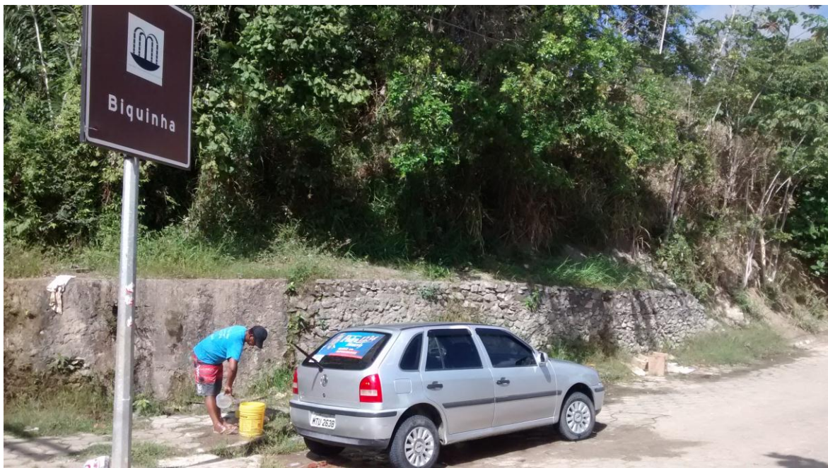
Foto 17 – Vista do muro de contenção existente
