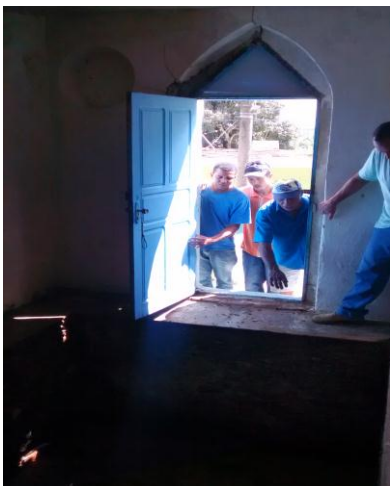
Foto 08 – Reservatório interno à edificação
